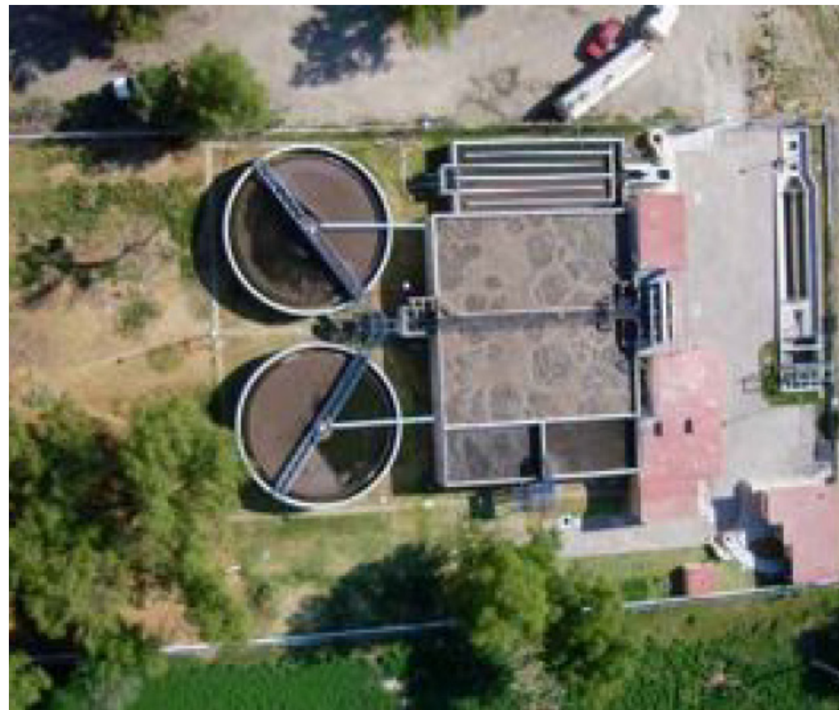
/ PLANTA DE TRATAMIENTO AGUA RESIDUAL, SILAO, GTO. /
